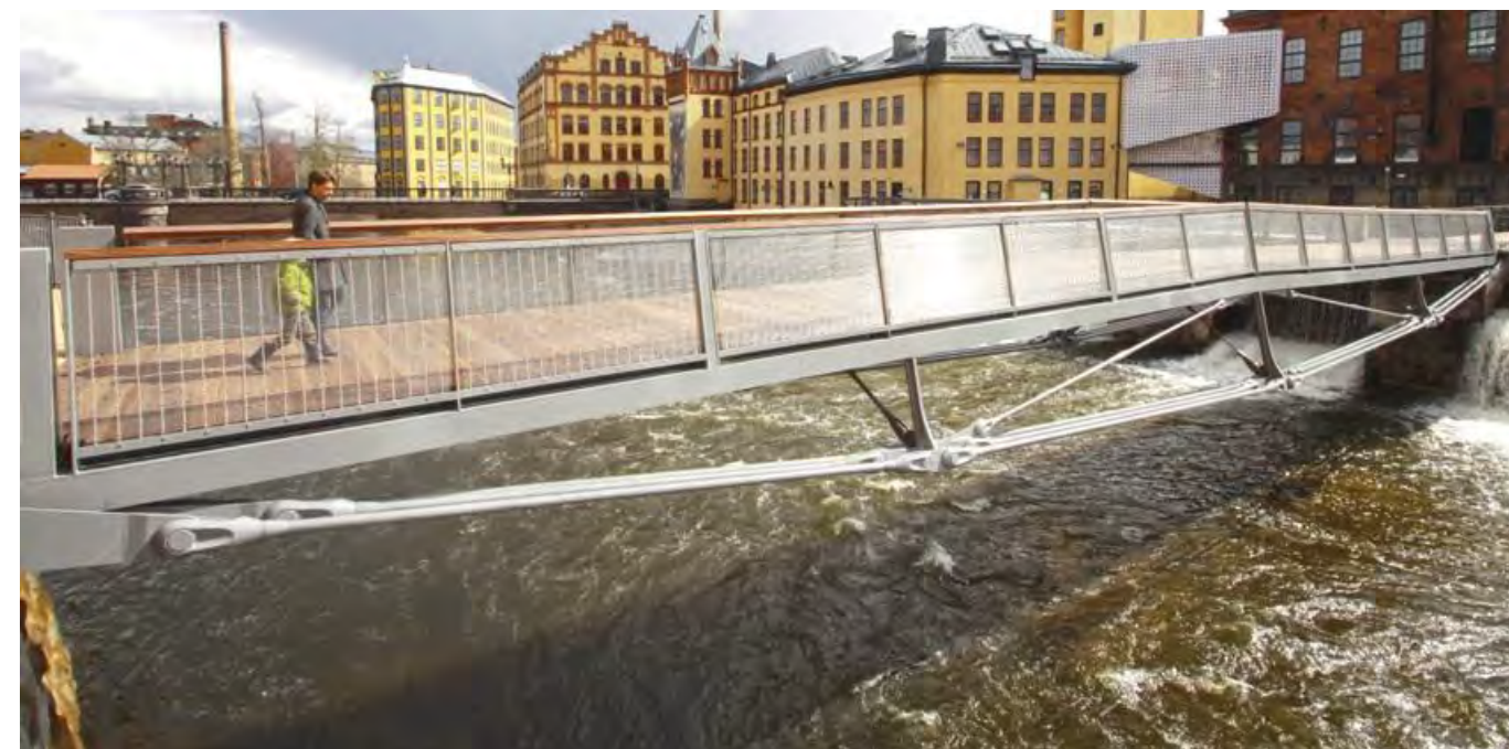
ASDO540-S M56 trækstænger blev anvendt til at danne spændelementer for disse brobuedragere på Kåkenhus fodgængerbro i Norrköping, Sverige.
