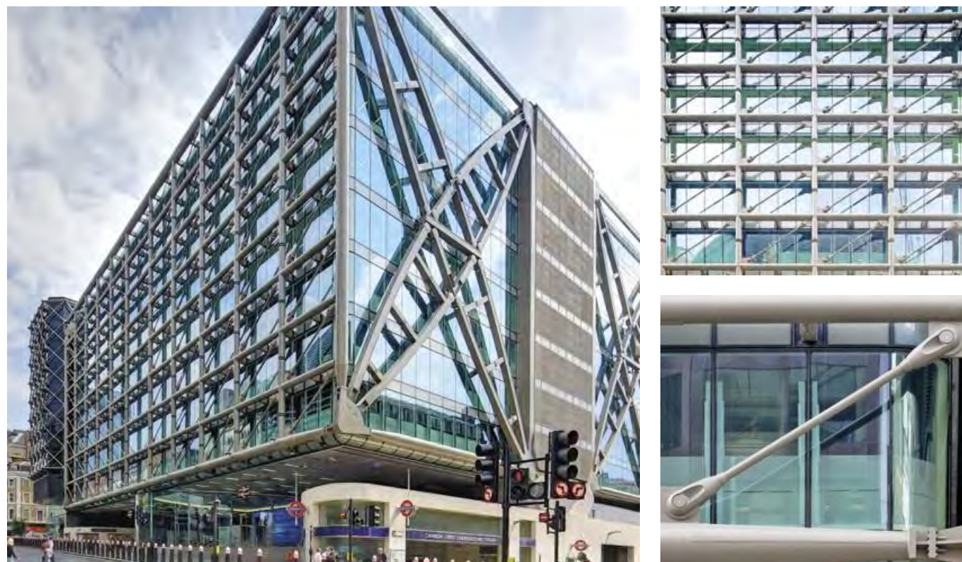
ASDO540-S trækstænger af typerne M76 til M160 blev brugt som spændelementer i dragerne som en del af denne unikke og strukturelt krævende kontorbygning beliggende på Cannon Place i London.
