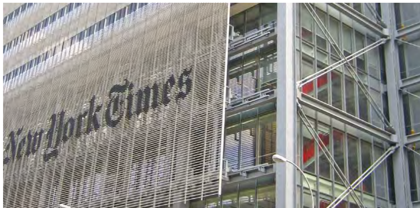
ASDO540-S tandemstænger blev brugt til at afstive avisens New York Times nye 52-etagers hovedkvarter.
