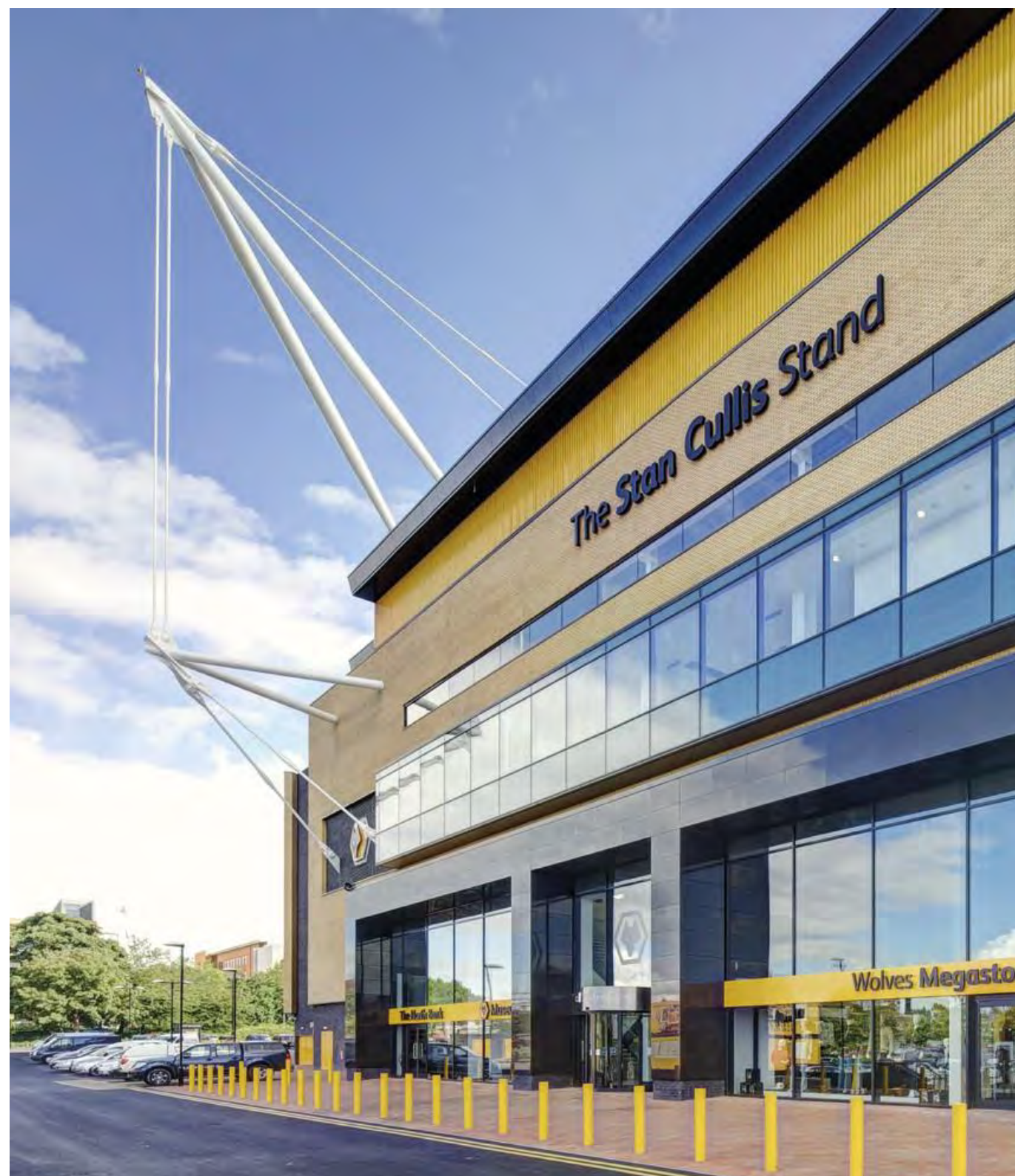
ASDO540-S trækstænger blev anvendt til den nye tribune hos Wolverhampton Fodboldklub i England, da det var det eneste system, der fandtes, som kunne understøtte de høje laster og forspændes in-situ.
