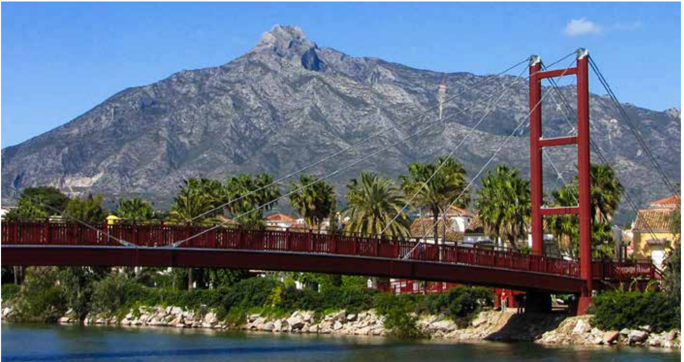
Gangbro Rio Verde, Marbella
